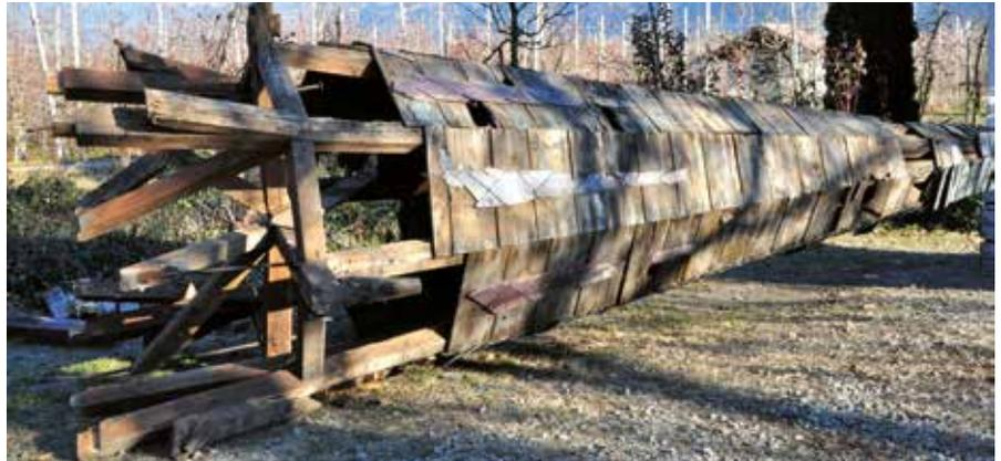
Der mit einem Kran abgenommen alten Turmhelm: faule und morsche Balken, sowie viele große Löcher entstanden in den Steinschieferplatten und der Holzverschalung
