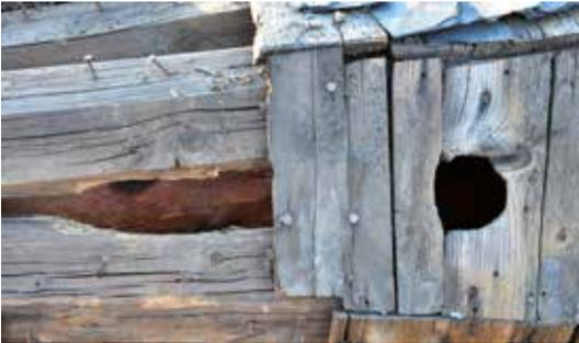
Detail der Holzverschalung mit einigen Löchern
